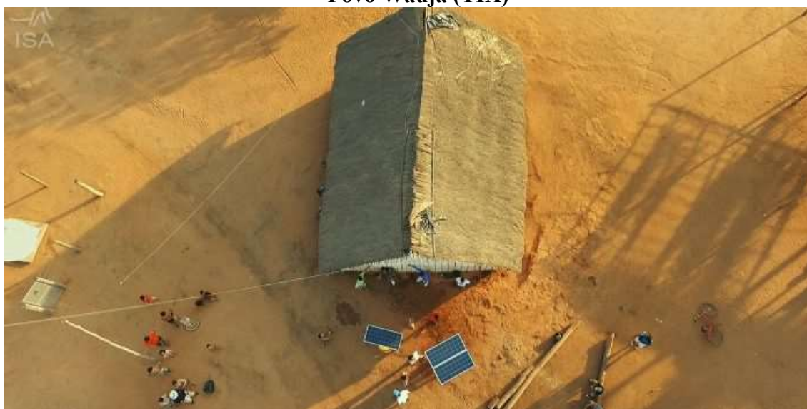
Figura 1 - Mutirão de instalação de placas de energia solar na aldeia Piyulaga do Povo Wauja (TIX)
